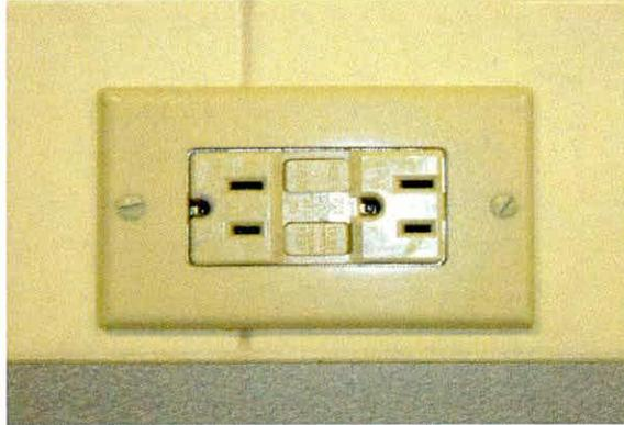
10. Toda instalación eléctrica debe estar libre de peligro (ej. Cables expuestos, empates inadecuados, lámparas colgando de los cables, falta de tapas de receptáculos, panel de distribución ("breakers") con espacios abiertos). Este ultimo señalamiento lo que significa es que entre un "breaker" y otro no puede haber un espacio que permita el contacto con la fuente de electricidad. Ver foto con deficiencia de espacios abiertos en panel
